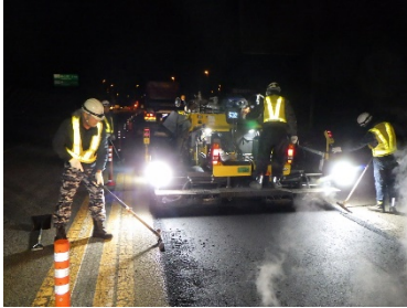
舗装補修工事
