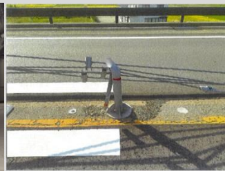
安全施設の損傷状況
